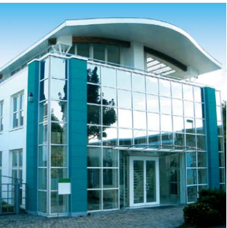
AIRNERGY AG, ZENTRALE HENNEF
